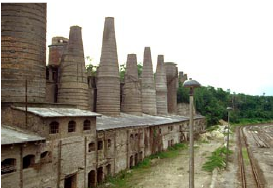
„Kathedrale“ des Kalks: die Schachtofenbatterie
